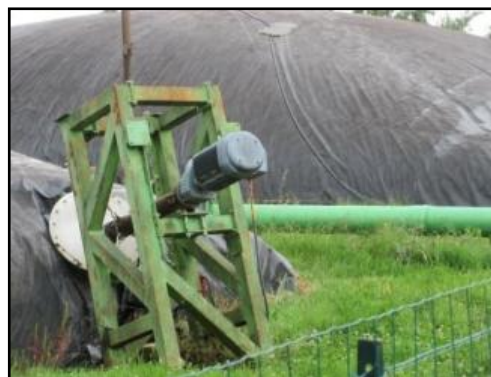
Moteur d'une des hélices insérée dans un des digesteurs souples (poches)
