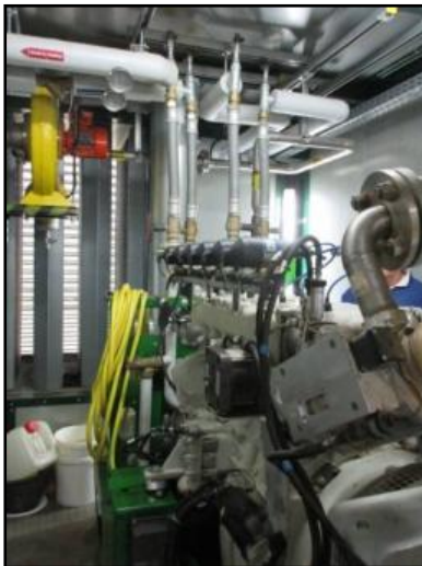
Le cogénérateur qui permet la transformation en électricité.
