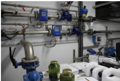
Salle de contrôle de l'unité de méthanisation de la Fromagerie.
