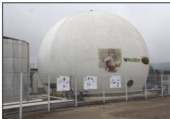
Le réservoir ou est accumulé le biogaz : une bache souple protégée dans une coquille métallique
